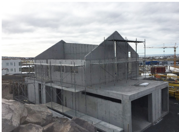
Mynd 13 Húsið að lokinni steypuvinnu.
